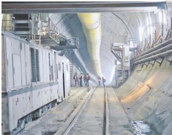
AVANCE. Imagen tomada de un video donde se aprecia parte del túnel ya perforado por "La Tapatía". El trayecto subterráneo de la Línea 3 del Tren Ligero lleva un avance de 60 por ciento.
