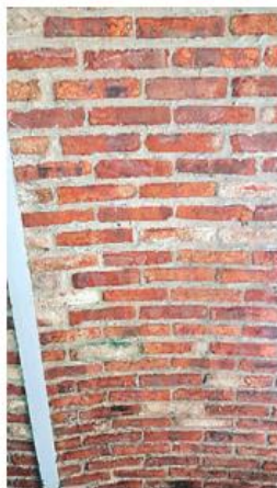
Aspecto de una bóveda de la finca
