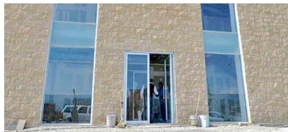
El edificio se encuentra en Zapotlán El Grande, pero no es aprovechado por el Instituto Jalisciense de Ciencias Forenses.
