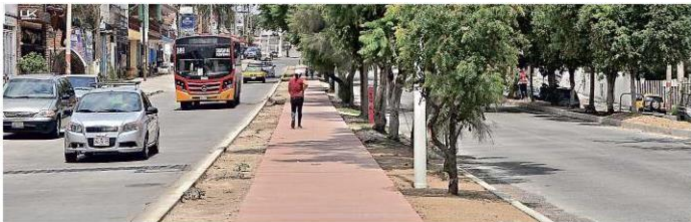
■ La ciclovía de Avenida Tonalá, según especialistas, dañaría la infiltración de agua, al compactarse el suelo.
