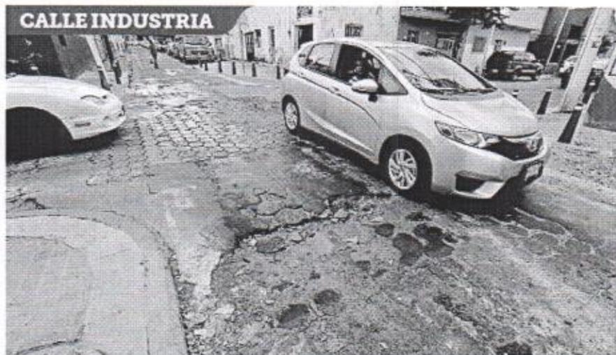
Esta vía de adoquín, al cruce con López Cotilla en el Centro de Zapopan, muestra sus entrañas tras el desgaste por el paso de camiones y autos desviados por la L3.
