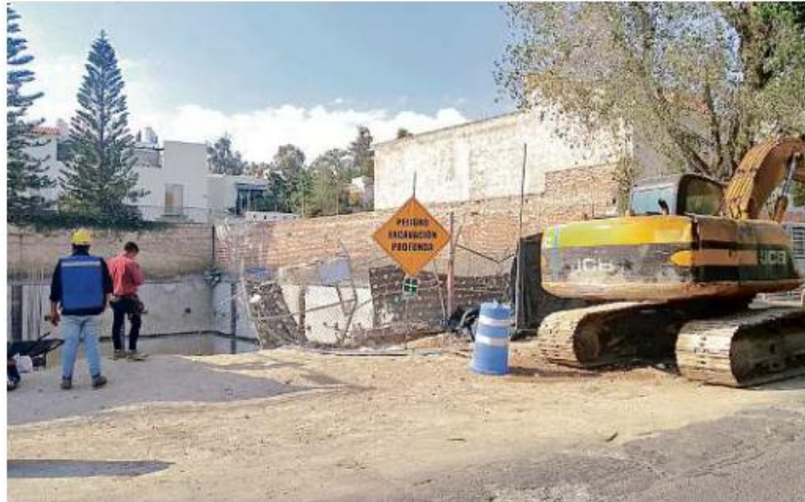
La torre se construye en el 885 de la Calle Altamira, en la Colonia Loma Blanca, en Zapopan.
