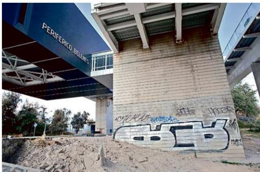
Los trabajos de la L3 están detenidos desde diciembre, cuando inició la nueva Administración federal. Para concluirlos se necesitan, según cálculos oficiales, 4 mil millones de pesos.
