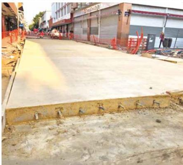
Las obras del Paseo Alcalde. Cortesía
