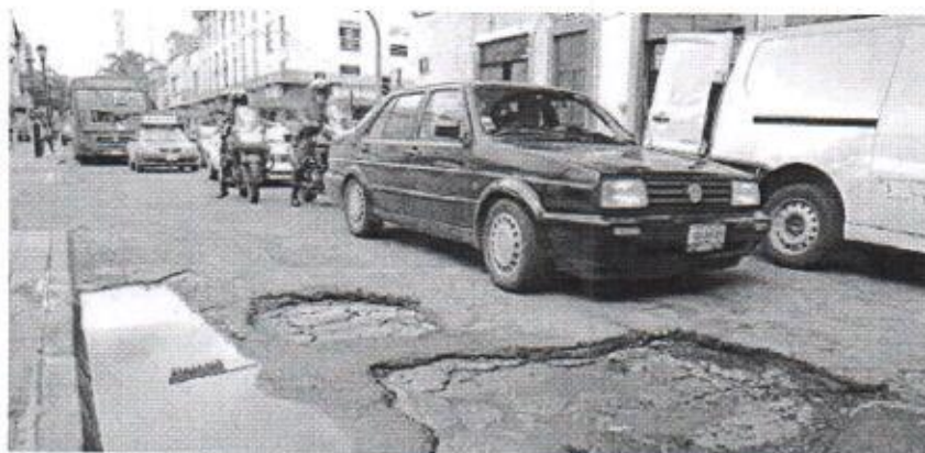
CENTRO TAPATÍO. Así está la Calle Prisciliano Sánchez al cruce con Ocampo, una de las rutas de desvío por los cierres de la Avenida Alcalde, debido a la construcción de la Línea 3.
