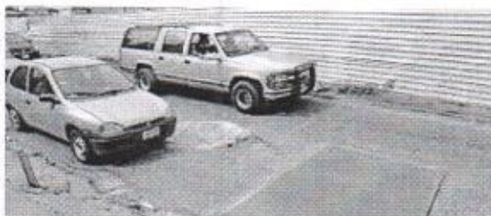
TLAQUEPAQUE. A unos metros del anterior agujero se tuvo que colocar esta placa de acero para cubrir un socavón.
