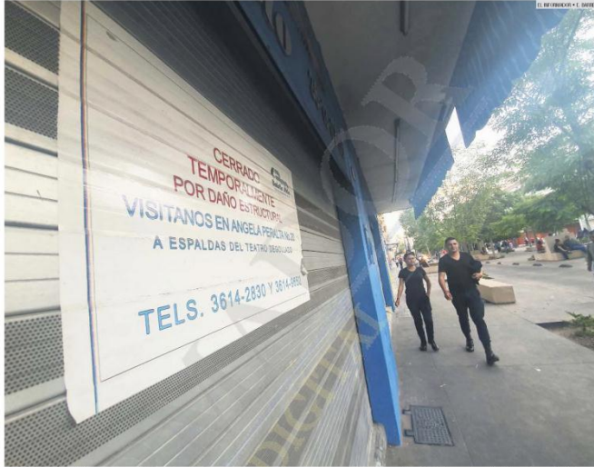
GASTO. La SCT confirma que ya erogó 4.8 millones de pesos por el concepto de reparaciones por daños a inmuebles. En la foto, una finca dañada en Paseo Alcalde.
