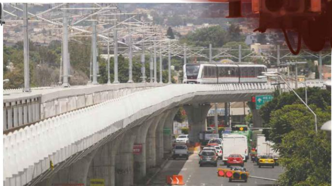
OJIALÁ. La nueva administración ha prometido que en diciembre terminarán las obras de la Línea 3 del Tren Ligero.
