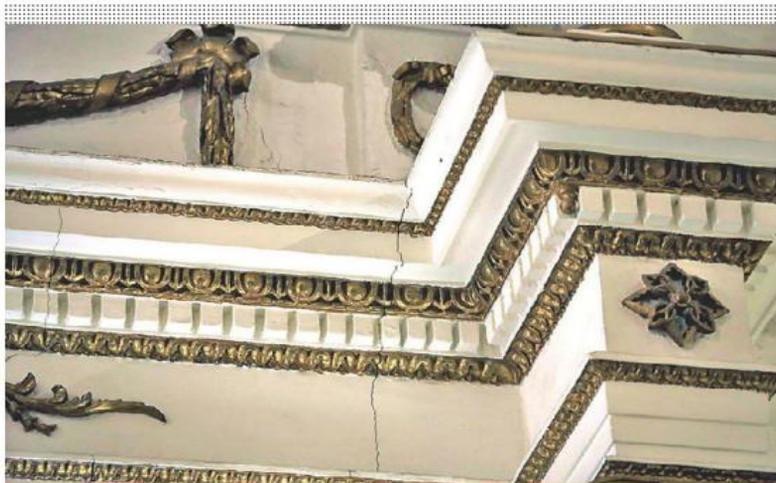
**LLEGAN GRIETAS.** Algunas fisuras ya se observan a simple vista en el interior de la Catedral por las obras de la Línea 3. El daño pudo acelerarse por una galería de filtración que se encuentra en la zona, dice investigadora. Foto: Fernando Carranza **P. 8 y 9**
