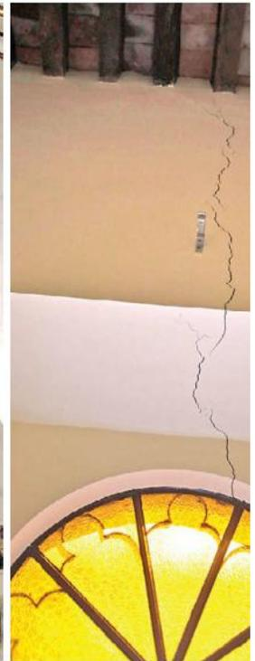
Una especialista de la UdeG señala que se aprecia un hundimiento hacia el arroyo de la Avenida Alcalde como factor de la línea de grietas que afectan a Catedral y fincas particulares
