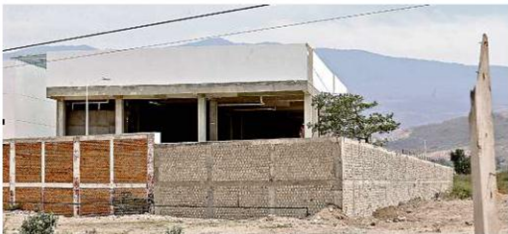
■ Una sección de la Comisaría de Tlajomulco aún se encuentra en obra negra.
