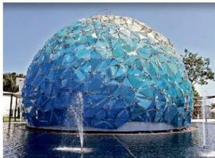
Las láminas de la esfera de Lunaria son de 6 milímetros de grosor y deberían ser de 10 mm.
