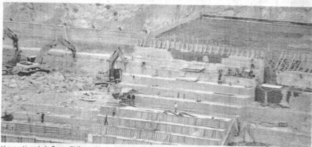
■ La cortina de la Presa El Zapotillo fue planeada originalmente de 105 metros de altura, pero se debate que quede en sólo 80 metros. Activistas están en contra de los daños que le generaría a Temacapulín.
