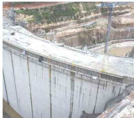
USO. El acueducto llevaría agua de la Presa El Zapotillo a León, Guanajuato.
