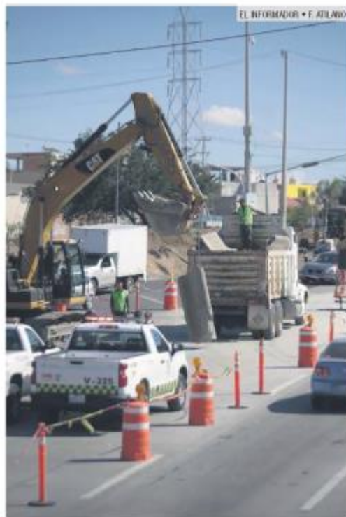
REPAVIMENTACIÓN. Terminará este mismo año.
