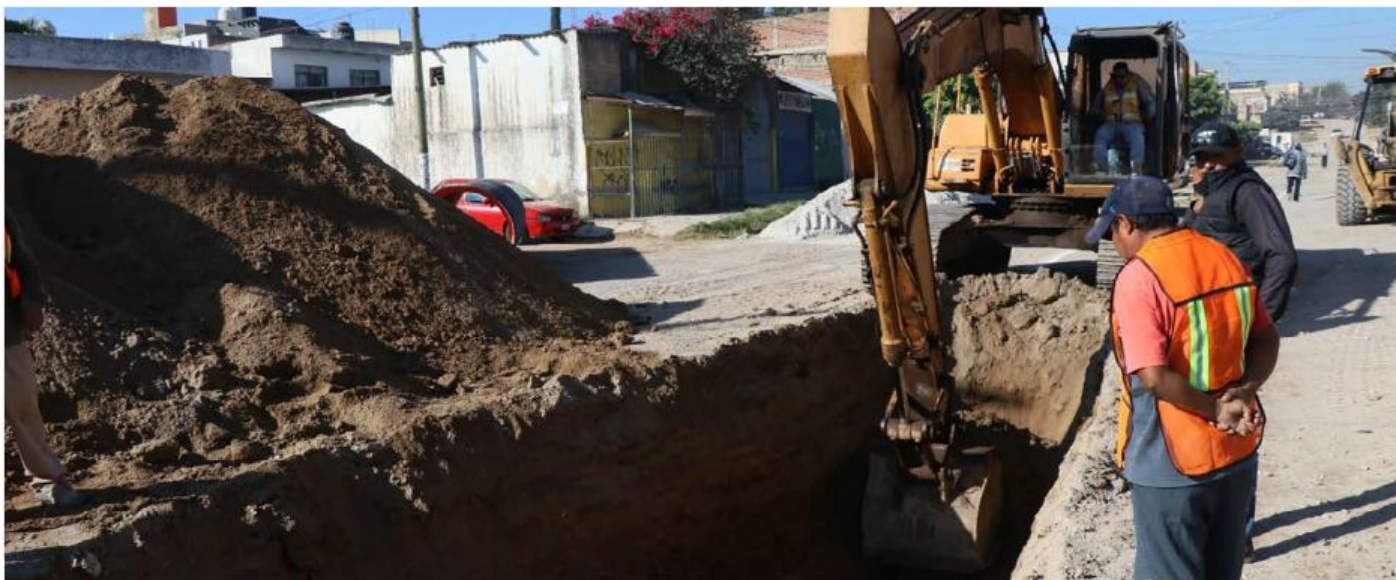
Los trabajos dieron inicio el pasado viernes por la tarde. ESPECIAL
