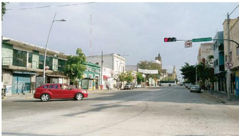
Los trabajos para Línea 3 del tren ligero han traído daños colaterales a vecinos y comerciantes
