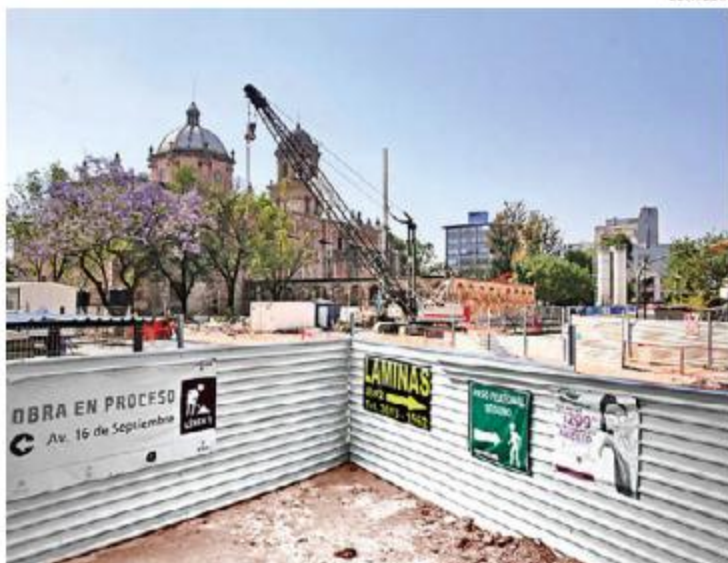
Las obras del tren ligero alrededor del templo de San Francisco
