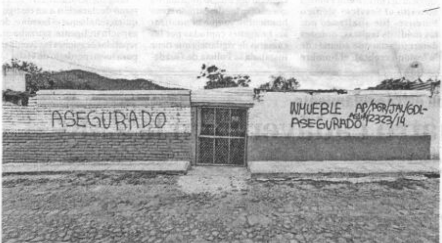
La autoridades pintaron las paredes de la fachada para informar que estaba asegurada
