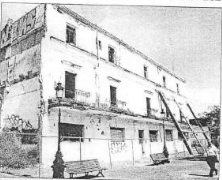
El alcalde de Guadalajara, Ramiro Hernández García, da la instrucción de retirar los escombros que obstruyen la visibilidad de la casa ubicada en la calle Independencia y Bienes Ajenos. Foto: Karen Barrios
