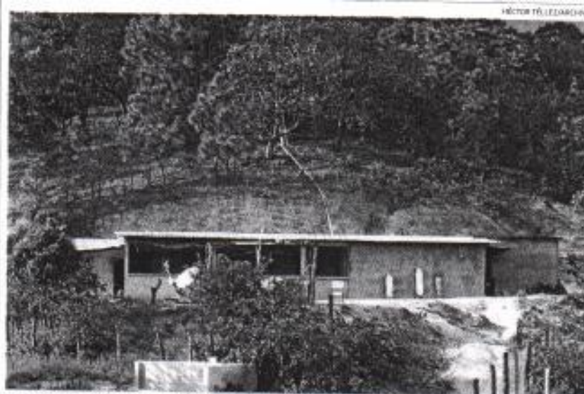
La casa en la que El Chapo se escondió en octubre pasado, cuando tuvo el primer enfrentamiento con la Marina.
