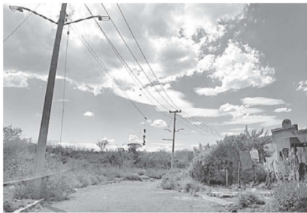
Las calles están fracturadas y llenas de pozos
