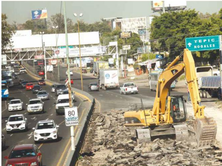
YA TIENEN RATO. Las obras del Viaducto Belenes se desarrollan en Periférico desde el año pasado.
