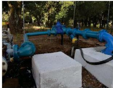
El alcalde Salvador Zamora supervisó personalmente el pozo. Foto: Elizabeth Ríos
