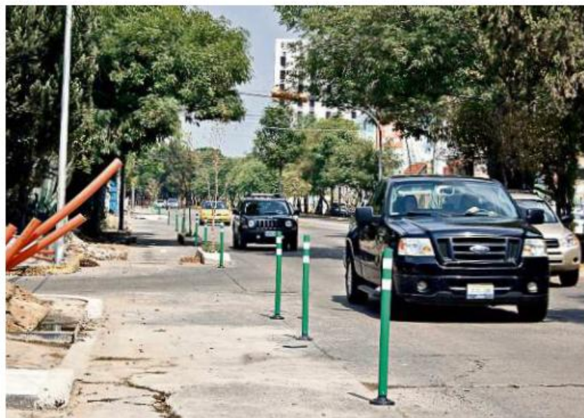
Debido a que la ciclovía les restará un carril en Avenida México, vecinos de la Colonia Vallarta Norte señalaron que ésta podría haberse construido en el camellón.
