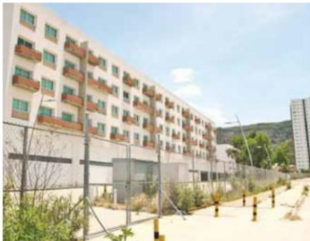
➤ LA MALEZA crece con riesgo a que ahí se genere un incendio y se consuman los vestigios de un edificio que desde sus cimientos fue construido en la ilegalidad.
