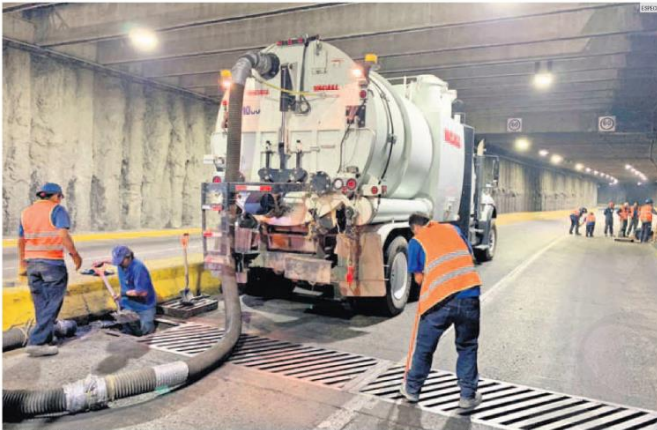
TRABAJOS. Se embocaron en avenidas donde antes corrían cauces, como Plutarco Elías Calles o Calzada Independencia.
