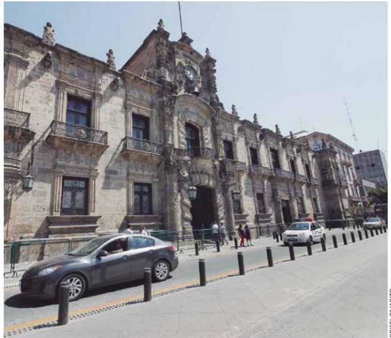
MAYOR. La actual administración dejará una deuda más grande que la que heredó.
