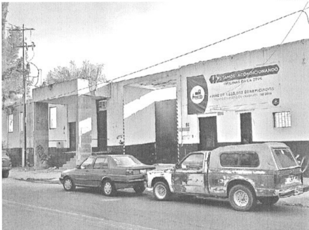
Desde el mes pasado las obras de construcción en Palmas 96 se encuentran prácticamente paralizadas
