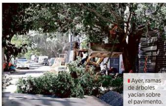
■ Sobre la Calle Venecia se levantó un tramo de pavimento y se instaló un baño
