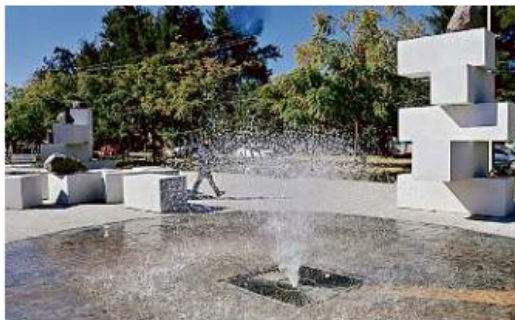
La explanada del Parque San Jacinto fue rehabilitada. También se reparó la fuente para darle más juego a la obra.
