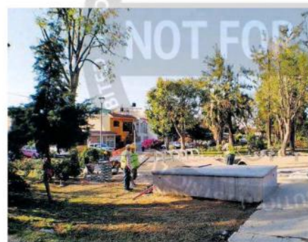
El alcalde supervisó los avances de la obra. FOTO: CORTESÍA / @DELTOROISMAEL
