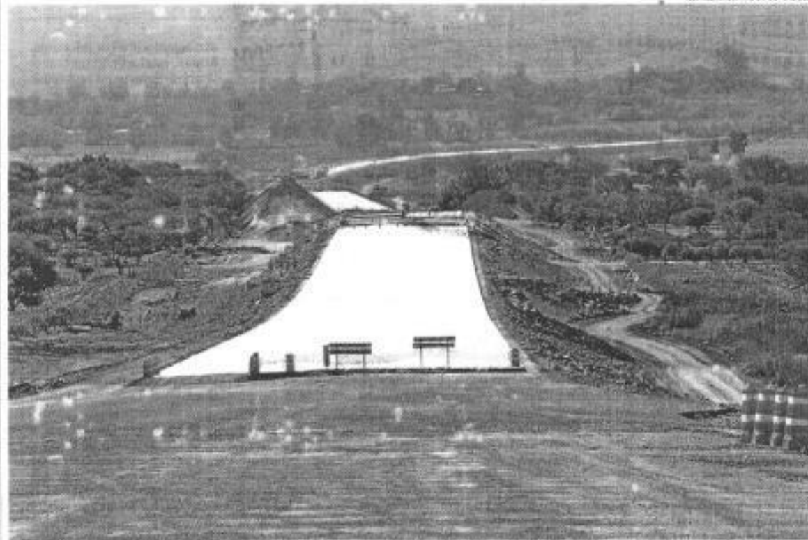
El tramo liberado constar  de 30 kil metros, ir  desde el cruce con la autopista a Los Altos hasta el entronque de la carretera a Chapala
