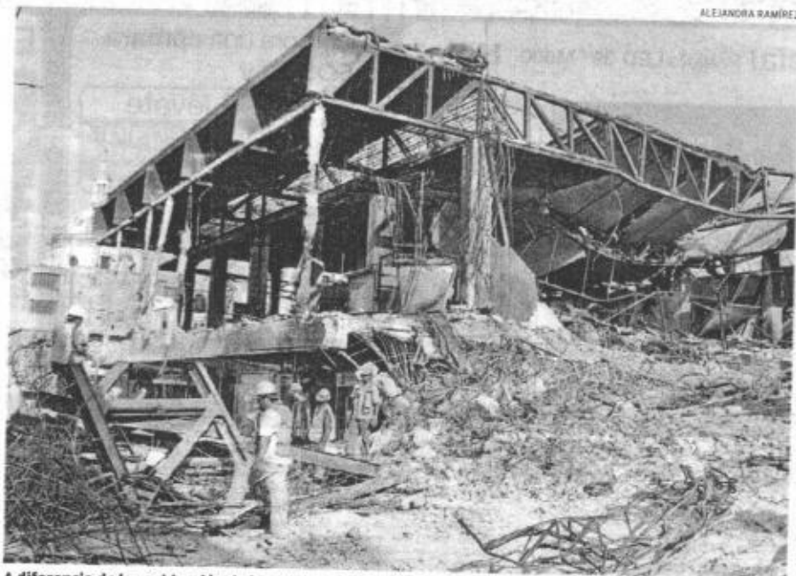
A diferencia de la reubicación de locatarios, la demolición sí tiene avances
