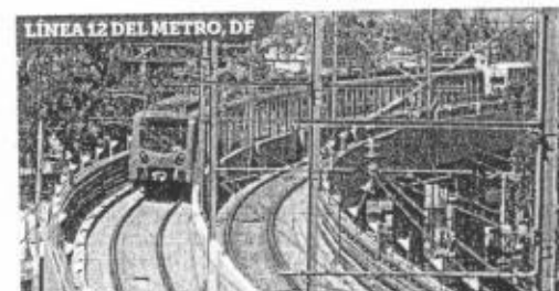
Además de la oposición de los ciudadanos, pues la vía elevada "partiría" el entorno urbano, la construcción resultó con fallas.
