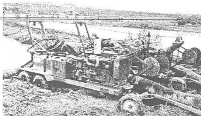
La Comisión Estatal del Agua sacó con bombas, con capacidad de 16 metros cúbicos por segundo, el agua de La Azucena y de Jardines del Castillo.
