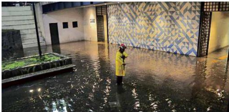
■ En la lluvia del 8 de julio, el agua subió entre 40 centímetros y 1.2 metros en Guadalajara. Una de las zonas más afectadas fue el Centro; la Estación San Juan de Dios del Tren Ligero se inundó.
