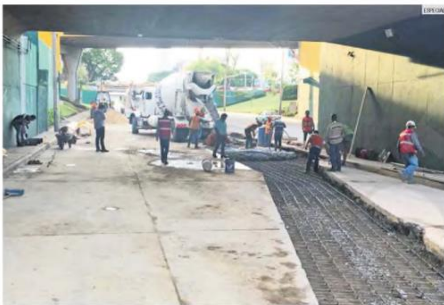
PROCESO. Los trabajos bloquearon los carriles centrales. El SIAPA anunció más trabajos, pero ya no habrá afectaciones.
