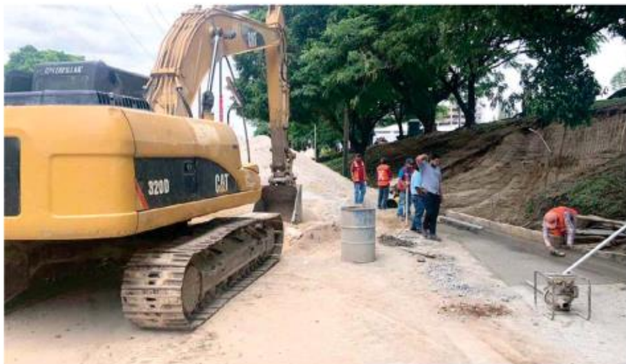
Confían en que el cárcamo reduzca las inundaciones. FRANCISCO RODRÍGUEZ
