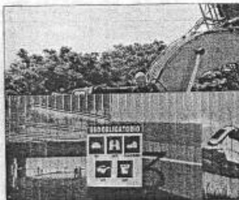
El decreto no contempla los descuentos solicitados por el ayuntamiento para los vecinos de las obras de la Línea 3 del Tren Eléctrico. Foto: Juan Martínez
