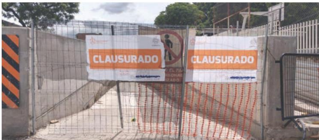
CLAUSURA. Han pasado más de dos meses de la clausura de la Estación La Normal que han dejado severos daños a los vecinos de la zona
