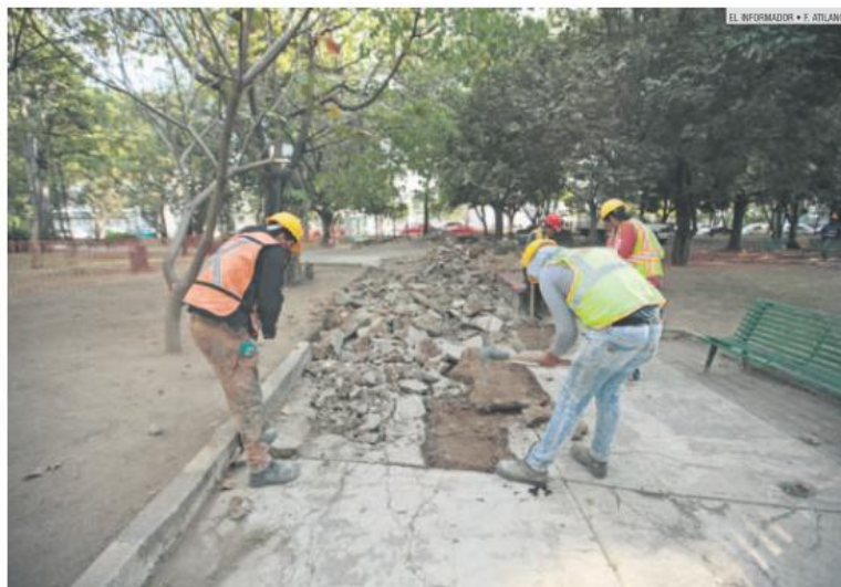
OBRAS DE RENOVACIÓN. La apuesta principal es rescatar la obra original del arquitecto Luis Barragán.
