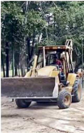
Entre las obras están las de rehabilitación del Parque Solidaridad.
