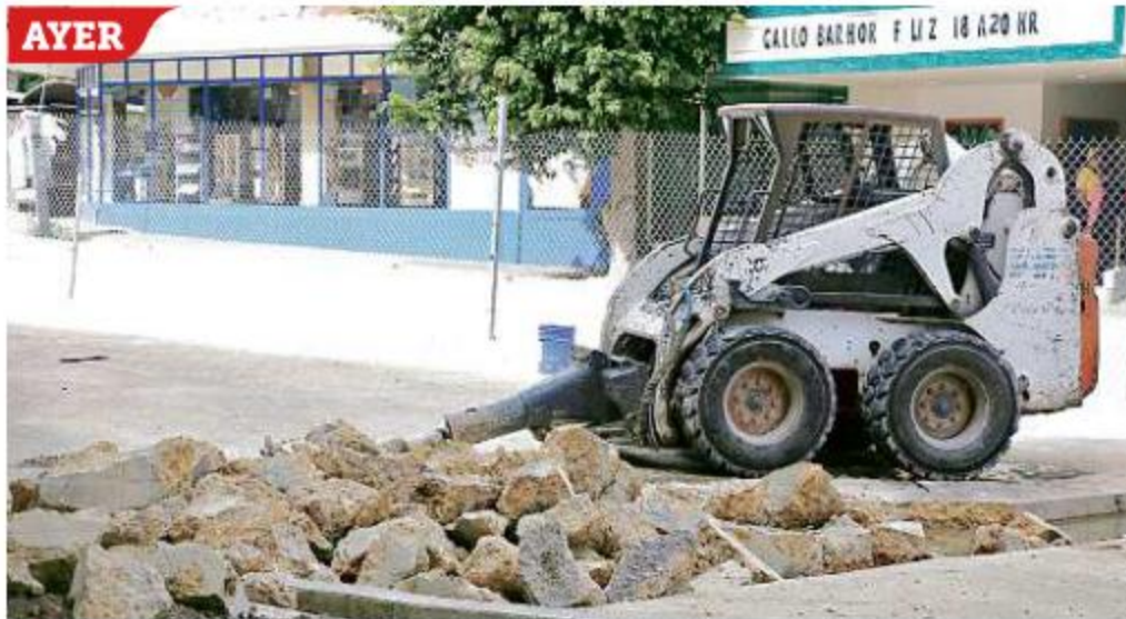
■ El "olvido" ocurrió en cruce Avenida Revolución con Calle Degollado, donde ayer ya se levantaba el concreto para colocar la nueva alcantarilla y evitar inundaciones.
