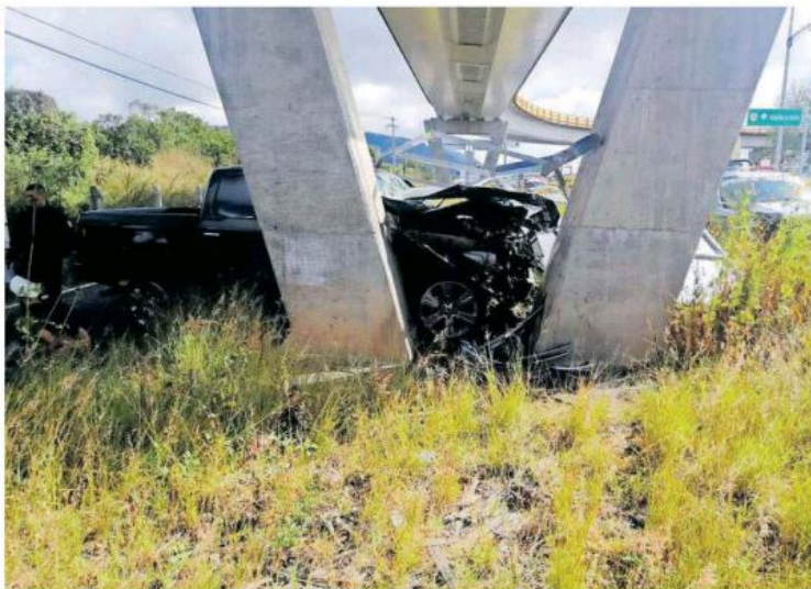
Así quedó el vehículo debajo del retorno elevado, en la carretera a Tepic. FOTO: CORTESÍA
