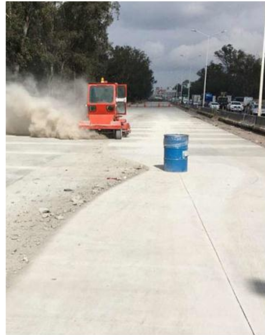
Nueva etapa de concreto hidráulico en Periférico. ESPECIAL
