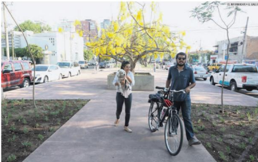
OBRAS. El tramo entre Washington y Niños Héroes era el último de la Avenida Chapultepec al que le faltaba rehabilitación.
