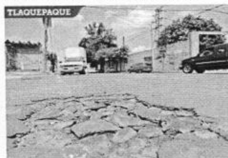
■ En la Calzada Delicias, en la zona de la Expo Ganadera, ya desapareció el asfalto y empieza a salir el empedrado.
