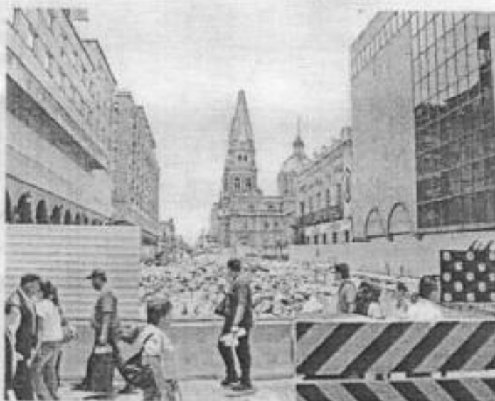
Debido a las obras de la Línea 3 del Tren Ligero, el tránsito por el Centro de Guadalajara se vuelve caótico en horas pico, con calles congestionadas por automovilistas y vehículos de la construcción.
