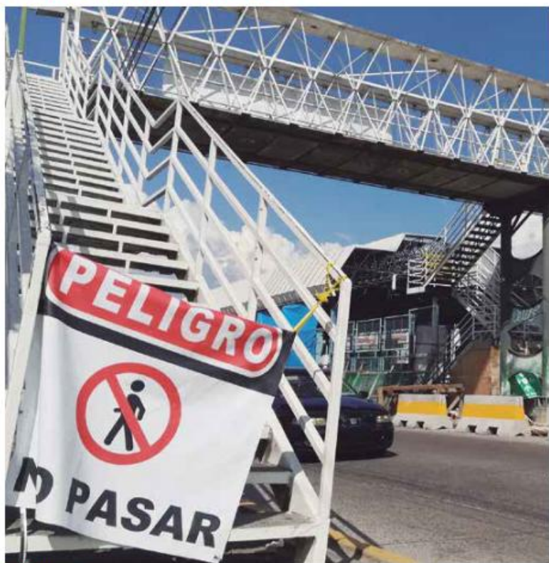
PROHIBIDO. Desde este fin de semana, la gente ya no pudo utilizar la estructura.
