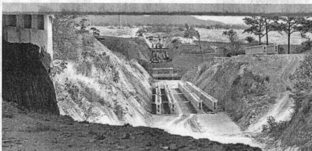
■ La construcción del tramo Guadalajara-Colima tardaría 2 años más, según ingenieros de la obra.
