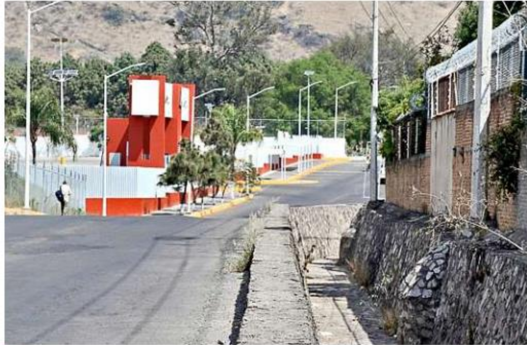
El bulevar sufri  de inundaciones severas durante el temporal pasado.
