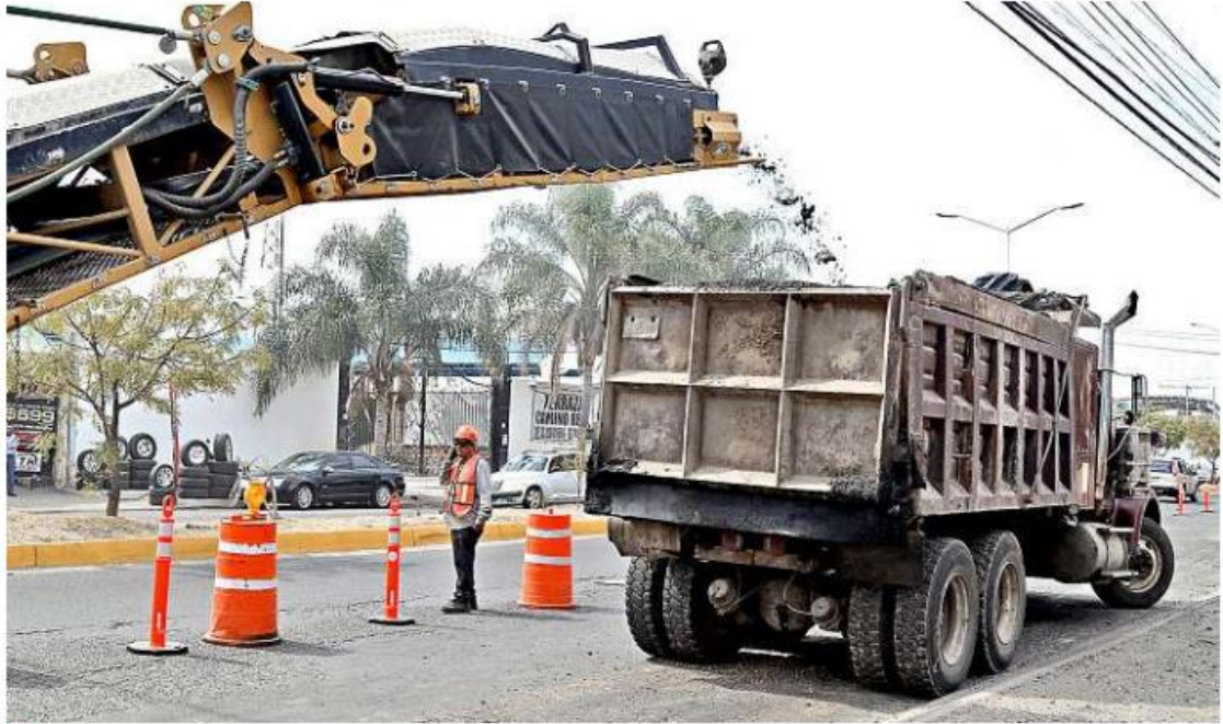
En Prolongación Colón se sustituirá la desgastada carpeta asfáltica, informó la SIOP.
