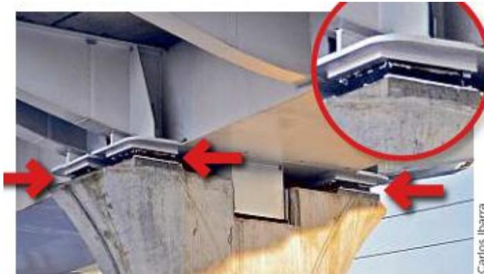
■ Sitio donde las placas de neopreno, que son de hule, se instalan entre la columna y la trabe para amortiguar el paso del tren.
