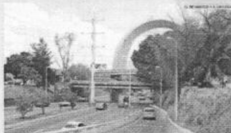
LÁZARO CÁRDENAS Y MARIANO OTERO. En caso de encharcamiento, se recomienda reducir la velocidad para evitar que el agua entre al motor del vehículo.
