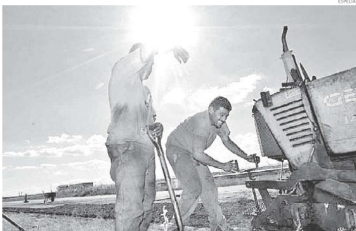
Las personas que trabajan expuestas al sol corren mayor riesgo
