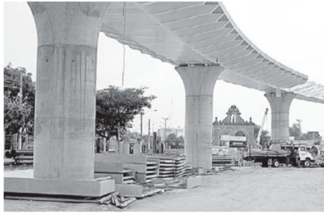
Obras del tren ligero en donde estará la estación basílica
