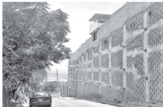
Nuevas viviendas se construyen en la zona
