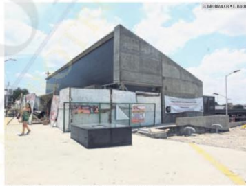
OBRA. En breve, la Estación Periférico Norte de la Línea 1 comenzará a dar servicio. En total se invierten dos mil 353 millones de pesos.
