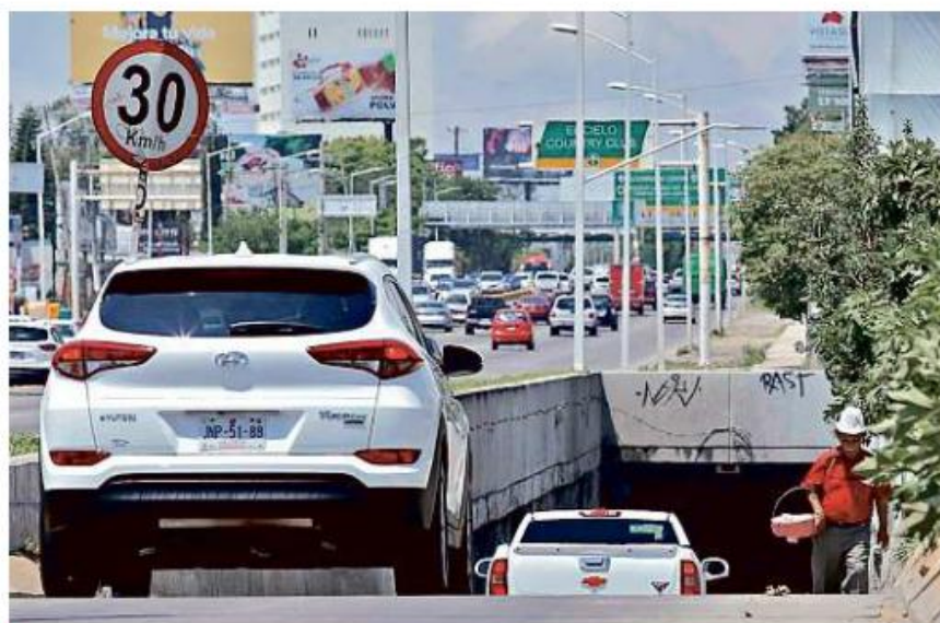
■ Ante la falta de un puente en un tramo de 2 kilómetros entre la Colonia Miguel de la Madrid y El Palomar, peatones utilizan un retorno subterráneo, exponiéndose a un accidente.
