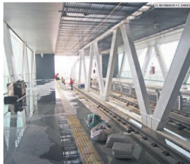
TERMINADOS. Continúan los últimos trabajos en todas las estaciones de los viaductos.
