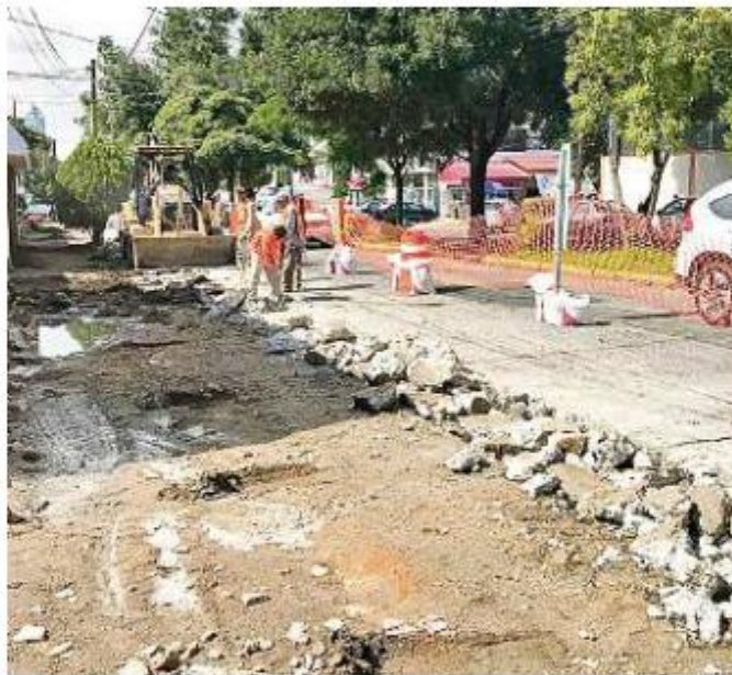
■ La ciclovía de Av. Juan Palomar y Arias iría de Manuel Acuña hasta Avenida México. Esta semana empezaron las obras.
