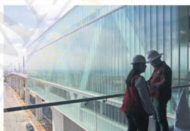
PENDIENTE. Mientras los viaductos serán terminados en esta administración, los trabajos del subterráneo de la Línea 3 serán heredados.
