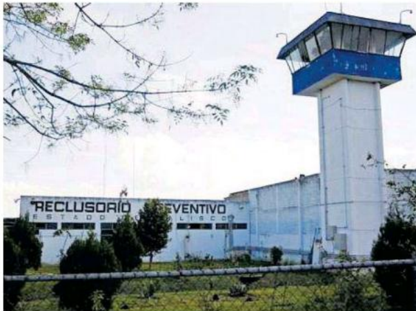
Deben pagar la reparación del daño para aspirar a este beneficio.
