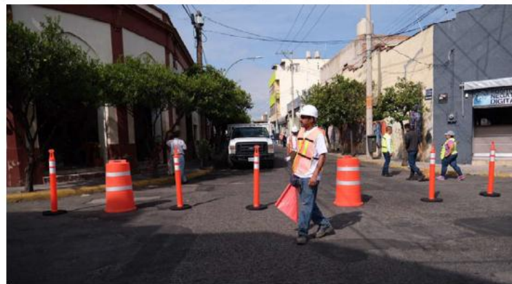
Repararán calles afectadas por las obras de la Línea 3. ESPECIAL
